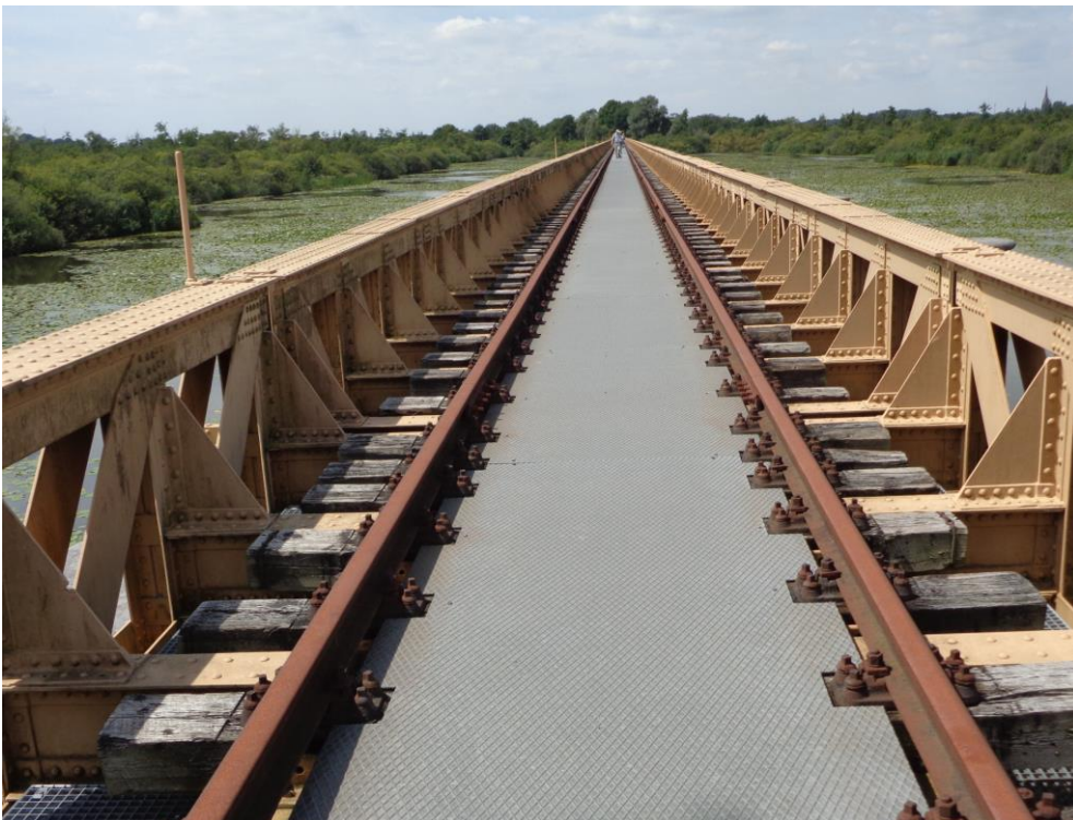
Moerputtenbrug Foto: Priscelline van de Pas
