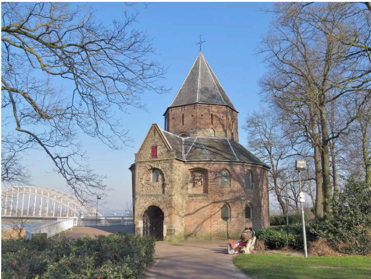
Valkhofkapel te Nijmegen, vanuit het zuidwesten: de grijze muurdelen bestaan voornamelijk uit tufsteen.
