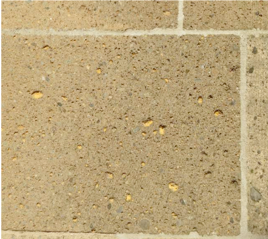
Stevenskerk, zuidzijde: Ettringer tufsteen met donkere (basalt-) insluitsels en lichtgele, deels al verweerde, puimsteen.
