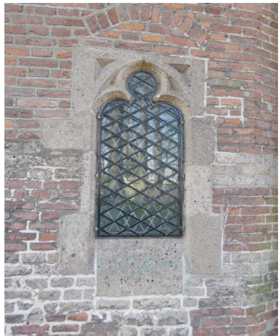
Valkhofkapel, oostzijde: venster met vernieuwde rand uit Ettringer tufsteen.
