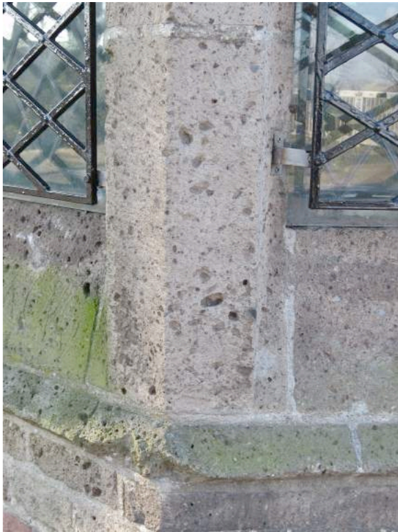
Valkhofkapel, oostzijde: detail van vernieuwde vensterrand uit Ettringer tufsteen.
